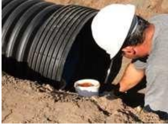
Figura 30: Aplicación de la pasta lubricante
