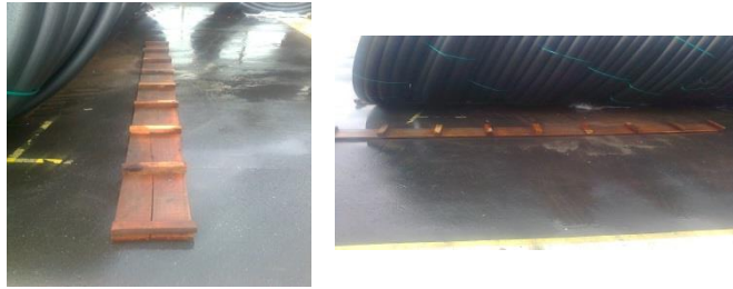
Figura 21 – “Trava-rola” de madeira, que deve ser posicionado abaixo dos rolos.
