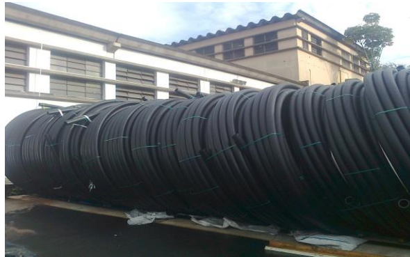
Figura 15 – Armazenamento de tubos na vertical (para DE 63 à 110 mm).
